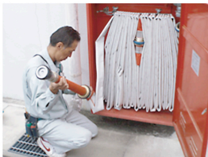
続いて試験用の装置を取り付け、実際にホースに圧をかけてテストをします。もし小さな裂け目や穴があっても見逃しません。
