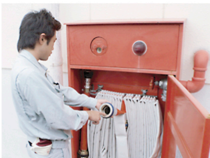
屋外の消火栓の点検風景。まずは目視…プロの目で見て、異常がないかしっかりと点検します。責任感を感じる瞬間ですね。
